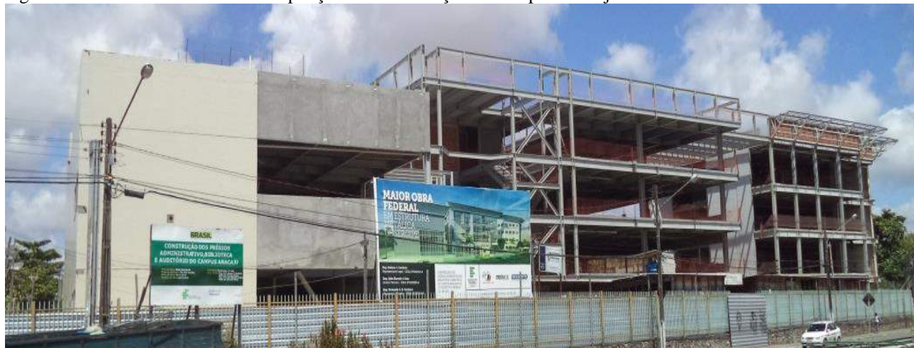
Figura 20 – Canteiro das obras de ampliação e reestruturação do campus Aracaju
