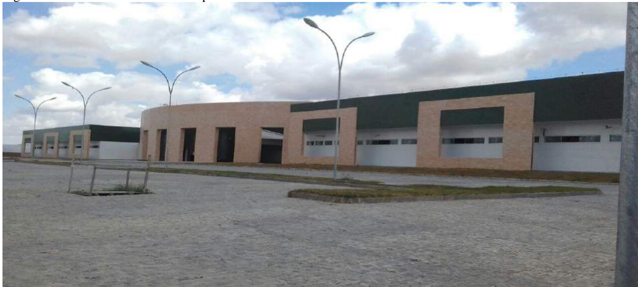
Figura 18 – Canteiro de obras do campus Itabaiana
