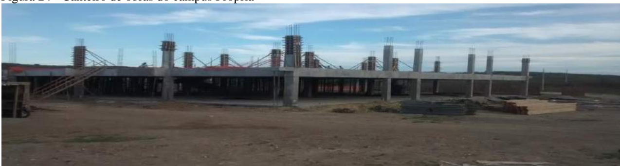
Figura 24 - Canteiro de obras do campus Propriá
