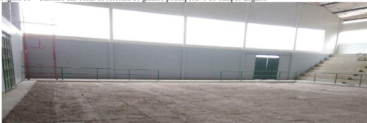
Figura 16 – Canteiro das obras de reforma do ginásio poliesportivo do campus Lagarto
