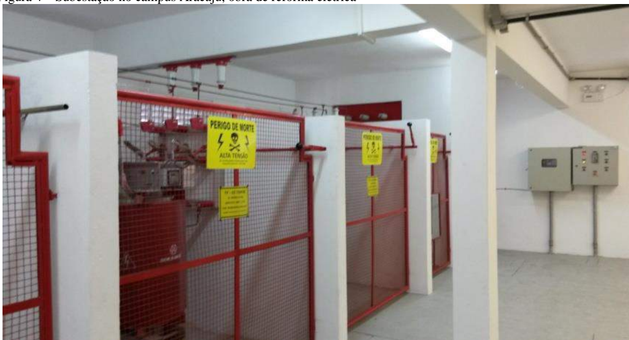
Figura 4 – Subestação no campus Aracaju, obra de reforma elétrica
