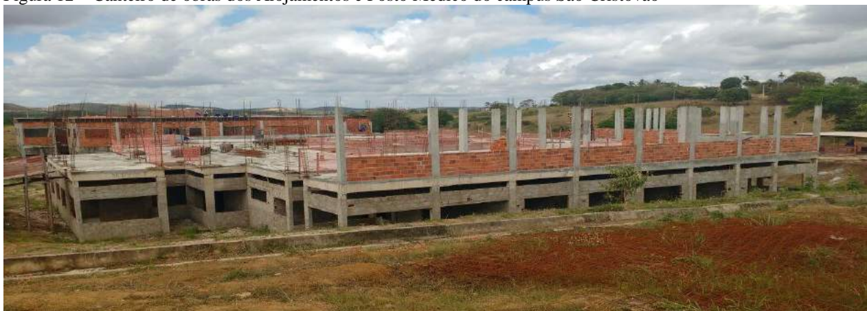
Figura 12 – Canteiro de obras dos Alojamentos e Posto Médico do campus São Cristóvão
