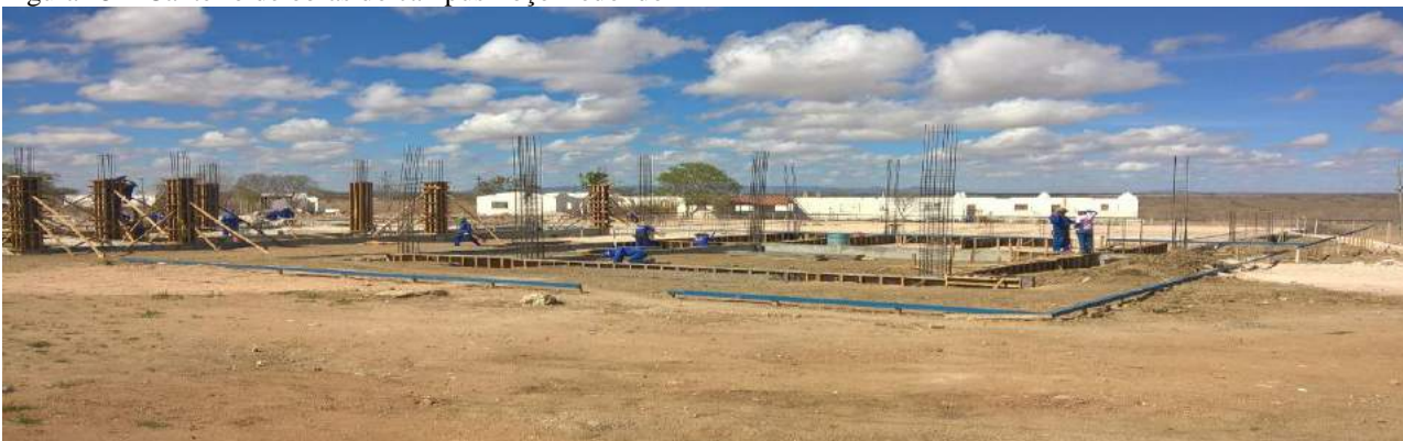
Figura 25 – Canteiro de obras do campus Poço Redondo
