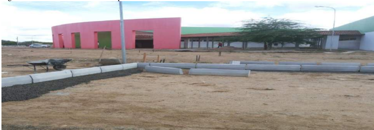
Figura 17 – Canteiro de obras do campus Nossa Senhora da Glória
