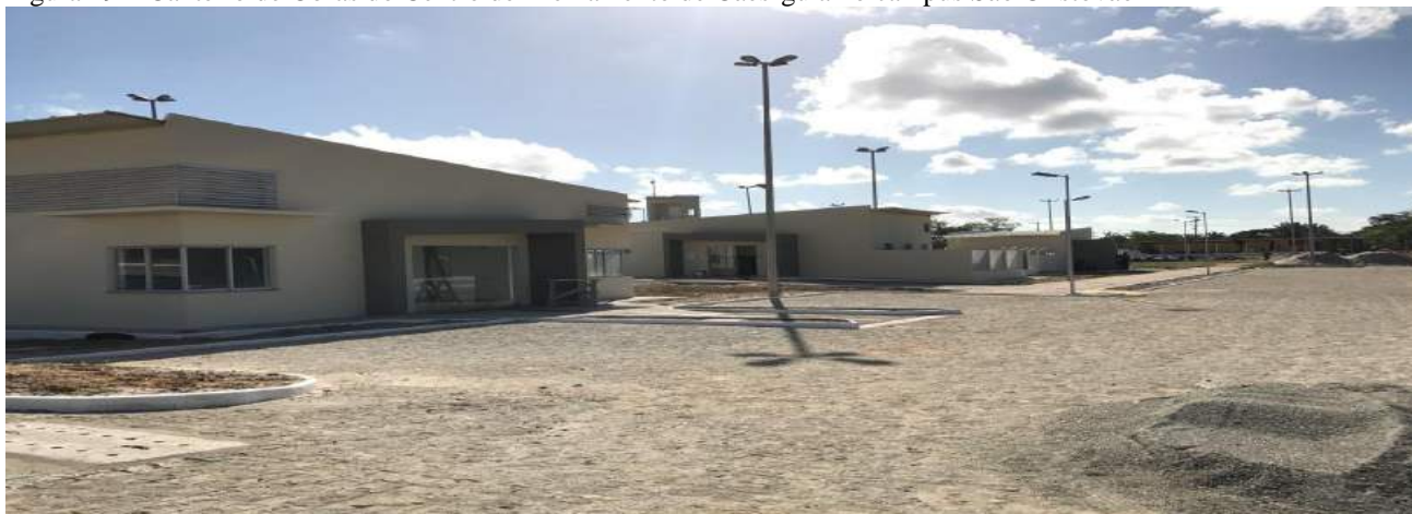
Figura 19 – Canteiro de Obras do Centro de Treinamento de Cães-guia no campus São Cristóvão
