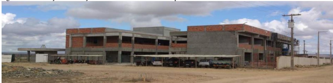
Figura 23 – Execução de serviços no canteiro de obras do campus Tobias Barreto
