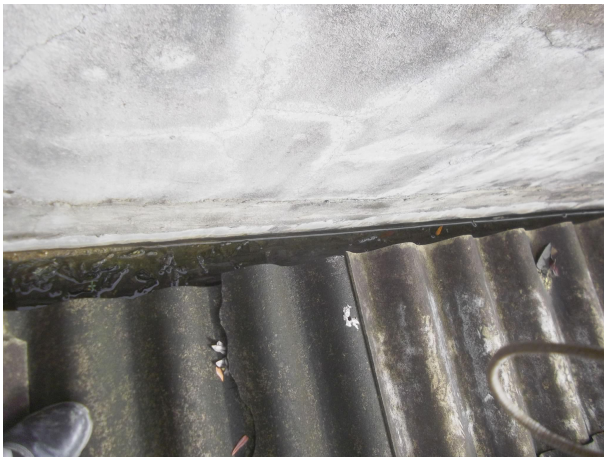
Foto 13 – Vista de telhas deterioradas, calha em alumínio com seção insuficiente para atendimento da área de contribuição da cobertura e falha de impermeabilização do revestimento da platibanda (07/05/2018).
