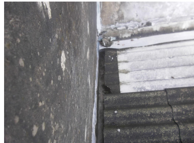
Foto 12 – Vista de telhas deterioradas e calha em alumínio com seção insuficiente para atendimento da área de contribuição da cobertura (07/05/2018).
