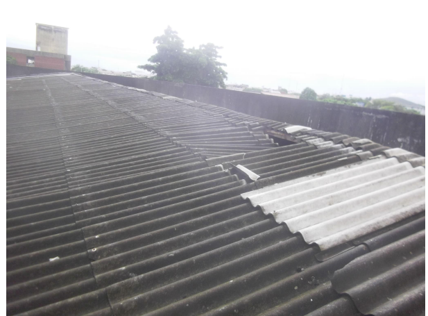
Foto 08 – Telhas deslocadas, deterioradas, sem parafusos de fixação e com reparos inadequados (07/05/18).
