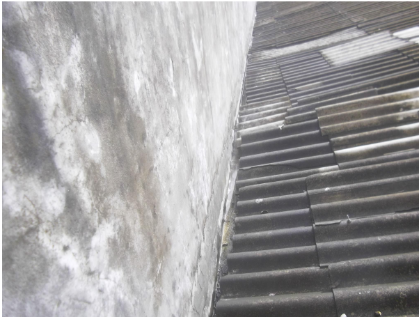
Foto 07 – Telhas deslocadas, danificadas, sem parafusos de fixação e com reparos inadequados (07/05/18).
