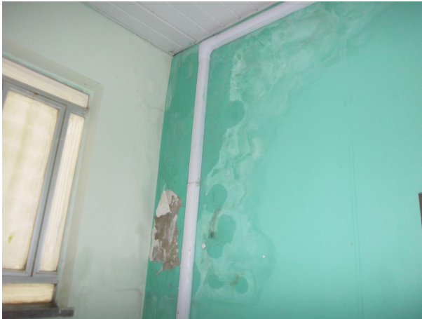
Foto 01 – Infiltração em parede, com deterioração de pintura (07/05/2018).
