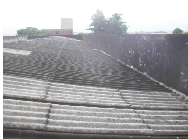
Foto 06 – Vista da cobertura com telhas desgastadas, sem parafusos de fixação, muitas apresentam trincas e/ou furos (07/05/18).
