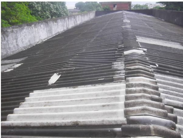
Foto 09 – Telhas e cumeeira deslocadas, deterioradas, sem parafusos de fixação e com reparos inadequados (07/05/18).).
