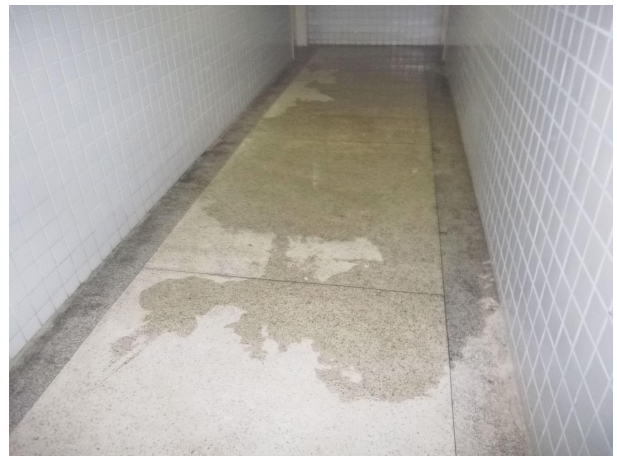
Foto 04 – Empoçamento no piso da circulação das salas de aula – 1º Pavimento (07/05/2018).
