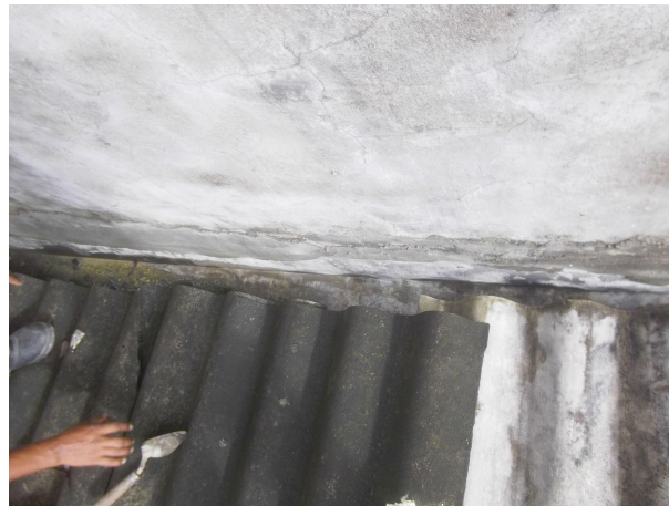
Foto 14 – Vista de telhas deterioradas, calha em alumínio com seção insuficiente para atendimento da área de contribuição da cobertura e falha de impermeabilização do revestimento da platibanda (07/05/2018).
