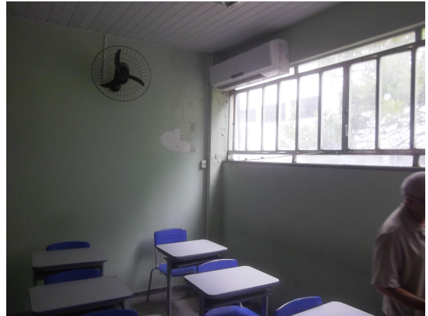
Foto 02 – Infiltração em parede, com deterioração de pintura (07/05/2018).
