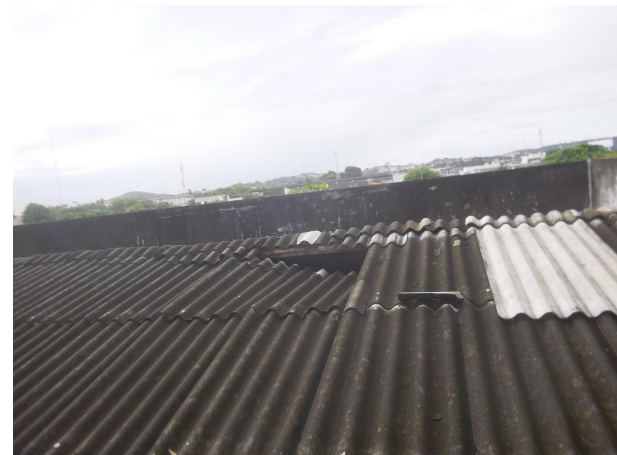
Foto 10 – Telhas deslocadas, deterioradas, sem parafusos de fixação e com reparos inadequados (07/05/18).
