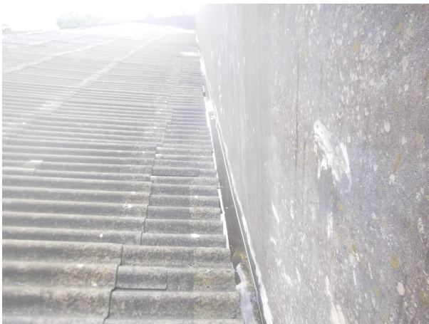
Foto 11 – Vista de telhas deterioradas e calha em alumínio com seção insuficiente para atendimento da área de contribuição da cobertura (07/05/2018).
