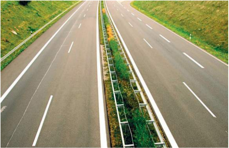
Figura 8. Sinalização viva em canteiro central de rodovia.
