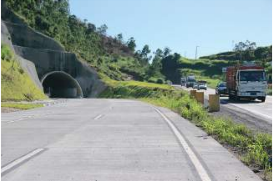
Figura 2 - Sinalização viva em saída de túnel Fonte: Site Gaucha Blog, 2015.
