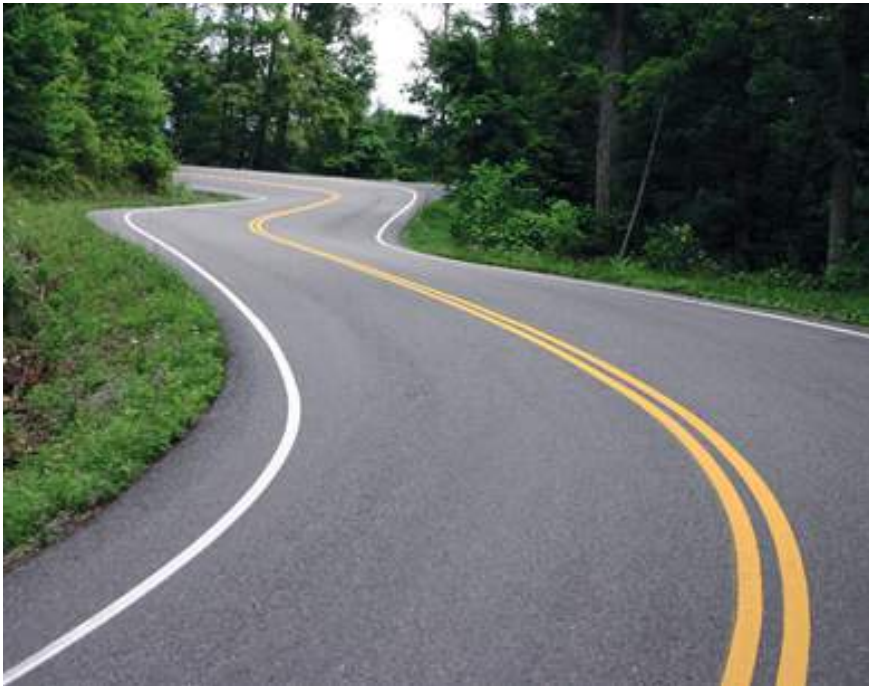
Figura 7. Trecho de pista com curva perigosa.
