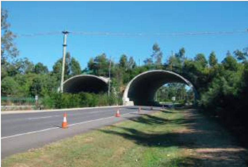
Figura 5 - Sinalização viva em ponte Fonte: Site Viver Bem Agora, 2015.
