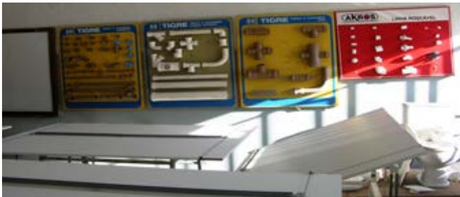
Figura 3 Laboratório de Instalações Hidrossanitárias do Curso Técnico Integrado de Edificações
