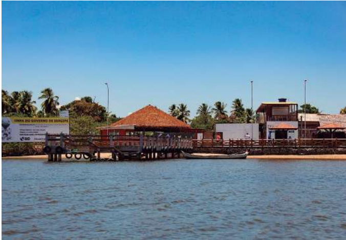
Figura 6: Construção do Atracadouro da Ilha Mem de Sá – 2019.
