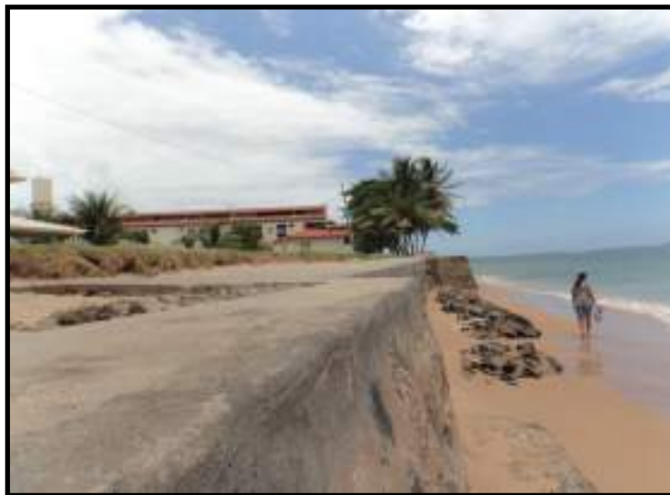
Figura 1: Contenção de maré às margens da praia, em Barra Grande, Vera Cruz - BA.
