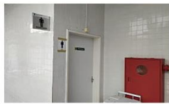
Acesso Banheiro Masculino 1.1
