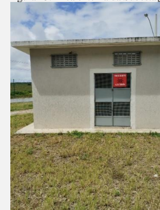
Figura 15. Área externa da Subestação
