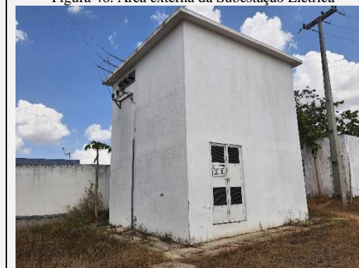
Figura 46. Área externa da Subestação Elétrica
