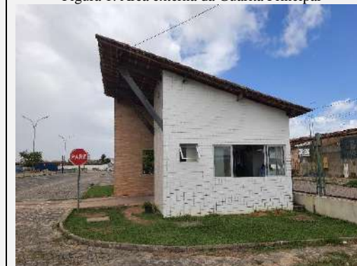
Figura 1. Área externa da Guarita Principal
