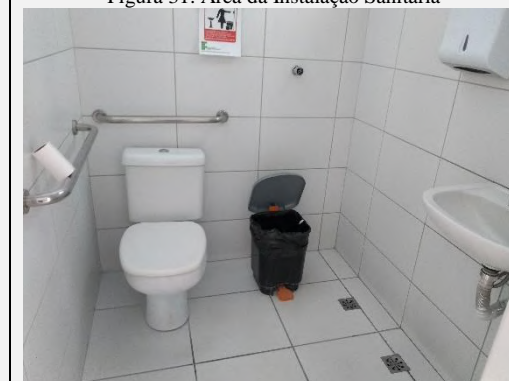
Figura 31. Área da Instalação Sanitária
