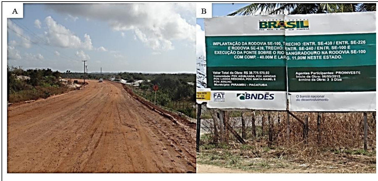
Figura 3. A. Retomada da pavimentação da SE-100 Norte. B. Placa Institucional com informes da obra da SE-100 Norte
