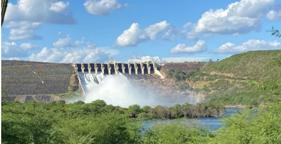
Foto 9 – Canindé de São Francisco - Usina Hidrelétrica de Xingó
