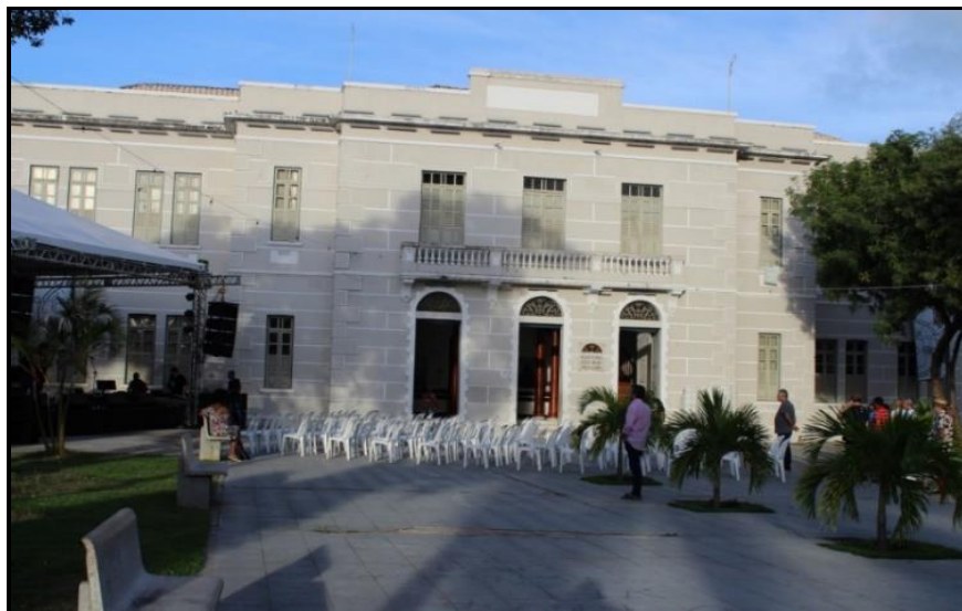
Foto 3 - Prédio da Alfândega - Centro Cultural de Aracaju
