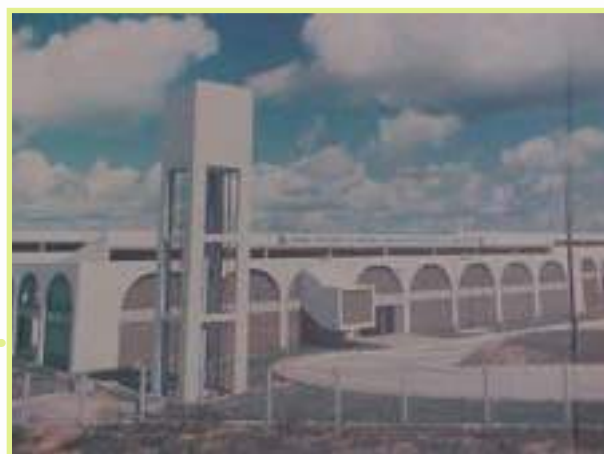
Figura 1: Unidade Descentralizadora de Lagarto. Fonte: IFS
